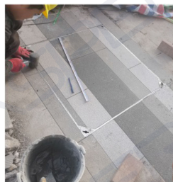
常规井盖安装后
