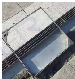
检修口安装后
